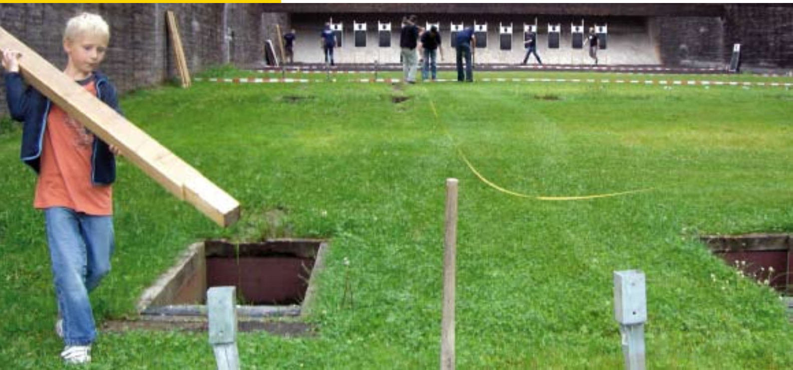
Tatkräftige Hilfe auch vom Nachwuchs: Die Mitglieder der SLG Ostmark Weiden bauten die Standortschießanlage der Bundeswehr eigens für die Disziplinen des BDMP um.
